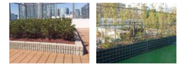
化粧ブロック施工例 ディアプランター施工例
