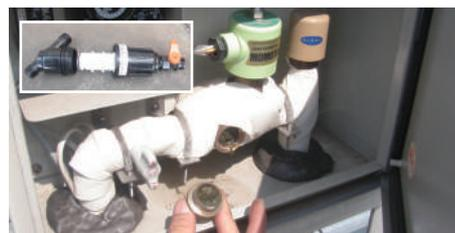
雨センサーを採用している場合、2年に1回程度、作動の確認を行ってください。なお、作動確認の際、内部のフィルターの汚れ具合も確認し、必要があればフィルター交換を行ってください。
