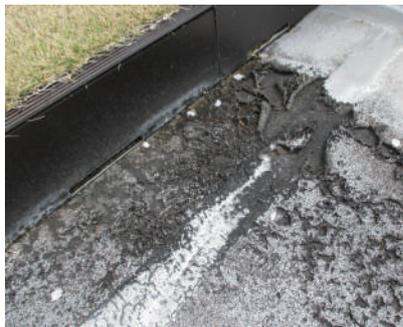
藍藻類や埃などの汚れが乾燥と湿潤を繰り返すとひび割れが起きます。その力が防水層にも伝わり、防水層を保護している表面の砂がめくれることがあります。これをマッドカーリング現象と言います。
