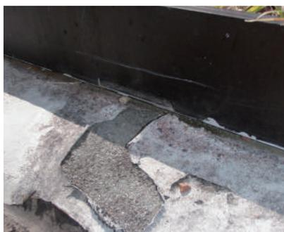
表面砂の隙間に水分が残った状態で保護塗料を塗布すると、接着強度が得られず、めくれることがあります。
