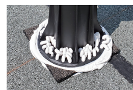
樹脂製束設置部の防水層と保護材
